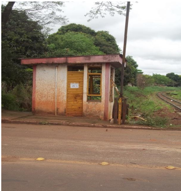
Figura 10: Condições atuais das cancelas relacionadas ao tráfego de trem em Sarandi - PR.
