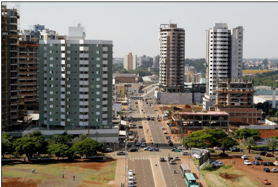
FOTO 3: NOVO CENTRO DE MARINGÁ - PR
