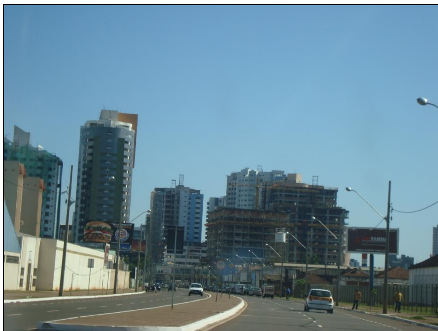
FOTO 4: NOVO CENTRO DE MARINGÁ – PR
