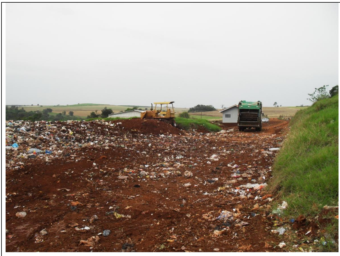
Foto 03: Máquina de esteira utilizada na acomodação dos resíduos. Fonte: Eliel, Rinaldo de Alencar. Setembro de 2011.
