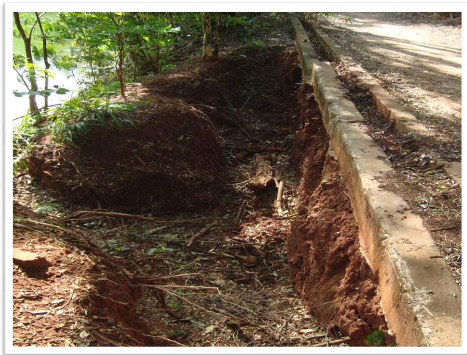
Figura 13 – Feição erosiva nas margens do lago do interior do Horto Municipal (23/09/11) Autora: Huanny Izabely Paiva Ribeiro
