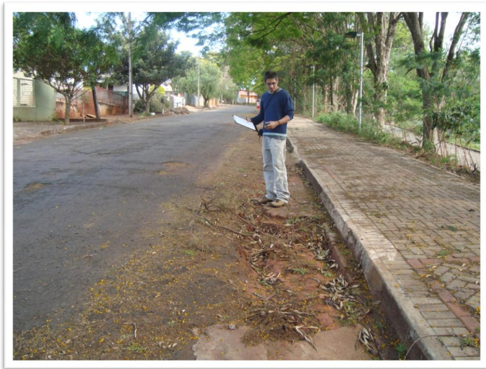
Figura 12: Mostra o início de feição erosiva próximo da Boca-de-Lobo “bueiro” (23/09/11) Autora: Huanny Izabely Paiva Ribeiro
