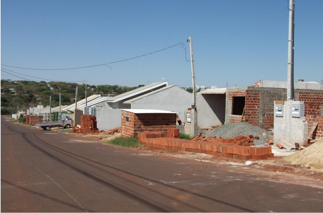
Figura 14 - Construção de novas casas geminadas, Jardim Paris.
