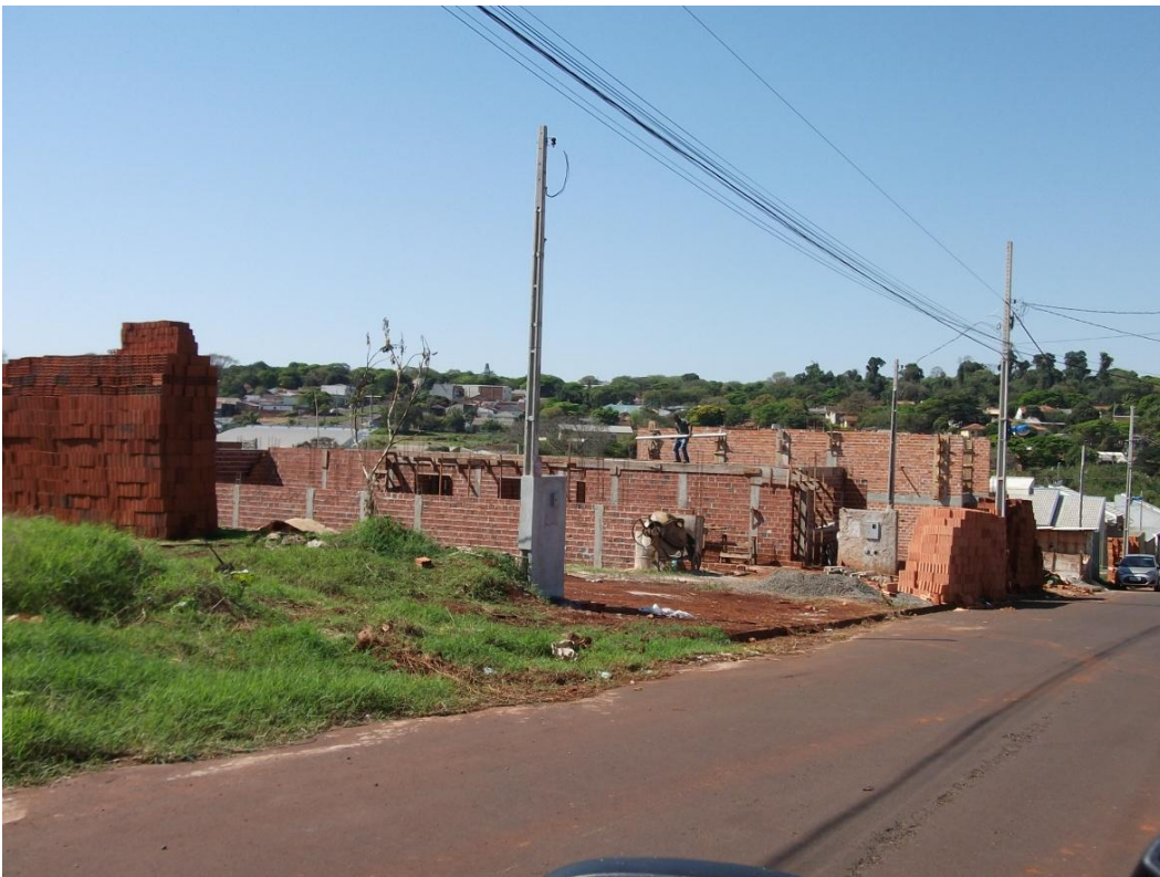
Figura 15 - Construção de novas casas geminadas, Jardim Paris.
