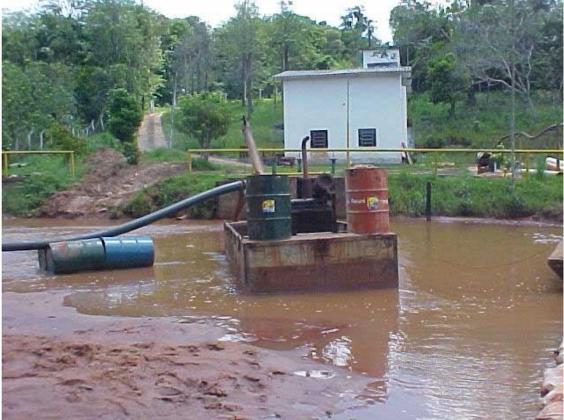
FIGURA 15 – Trabalho de dragagem na área com alta concentração de sedimentos, próximo ao ponto de captação de água da SANEPAR. Foto J.A.Costa, 2010.
