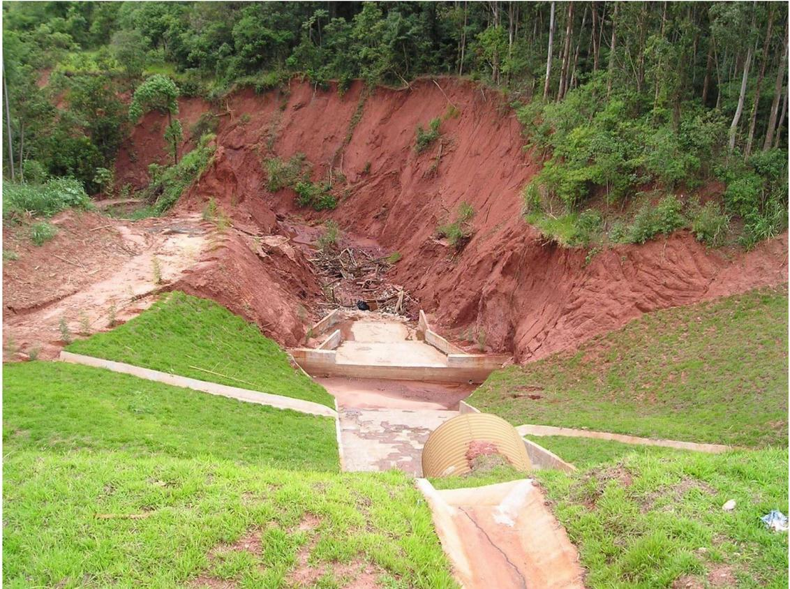
FIGURA 1 – Detalhe do processo erosivo na cabeceira da nascente nº 1. Foto J.A.Costa, 2010.
